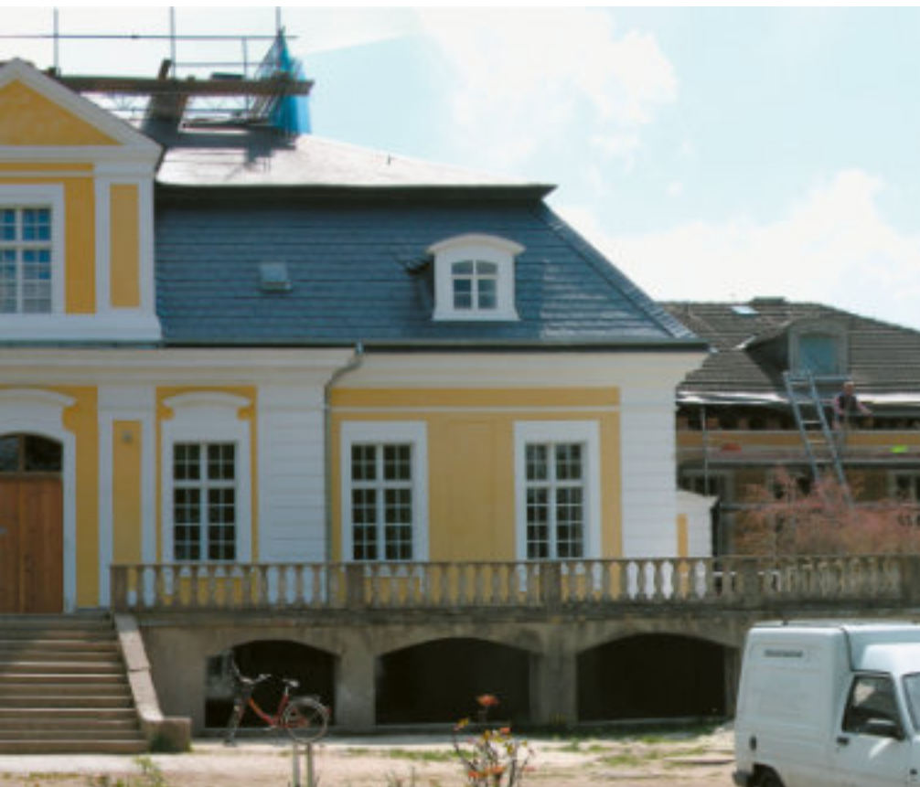
Nordansicht im Mai 2005.
